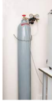
Şekil 8.12: Sıkıştırılmış gaz içeren tüplerin duvara sabitlenmesi
