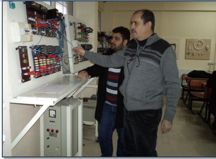
■ Elektrik Makineleri Laboratuvarı'ndan bir görünüm.
